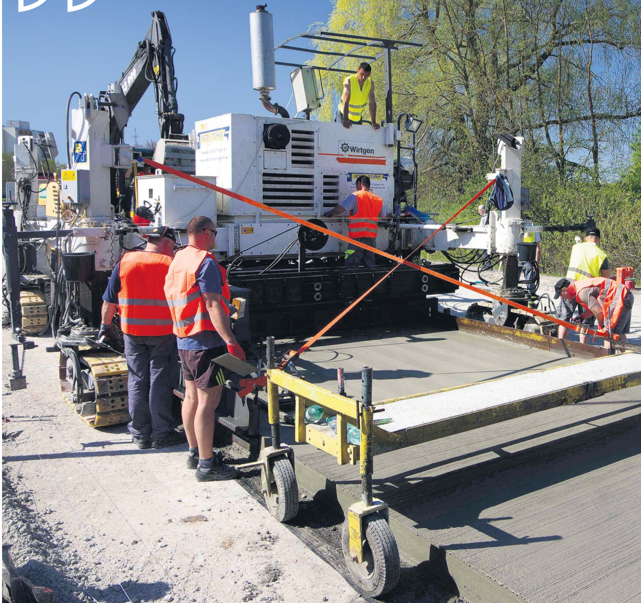
Tallinna betoontee katselõigu ehitamine. Vt lähemalt lk 12
