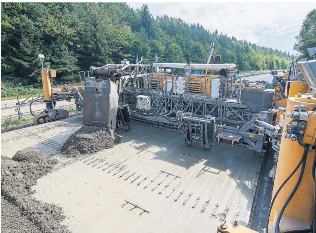
A1 ehitamine Trieri lähedal. Ehitaja – Berger Bau. Alumisse betoonikihti on paigaldatud ka tüüblid ja külgakrud. Käib pealmise betoonikihi paigaldus.
