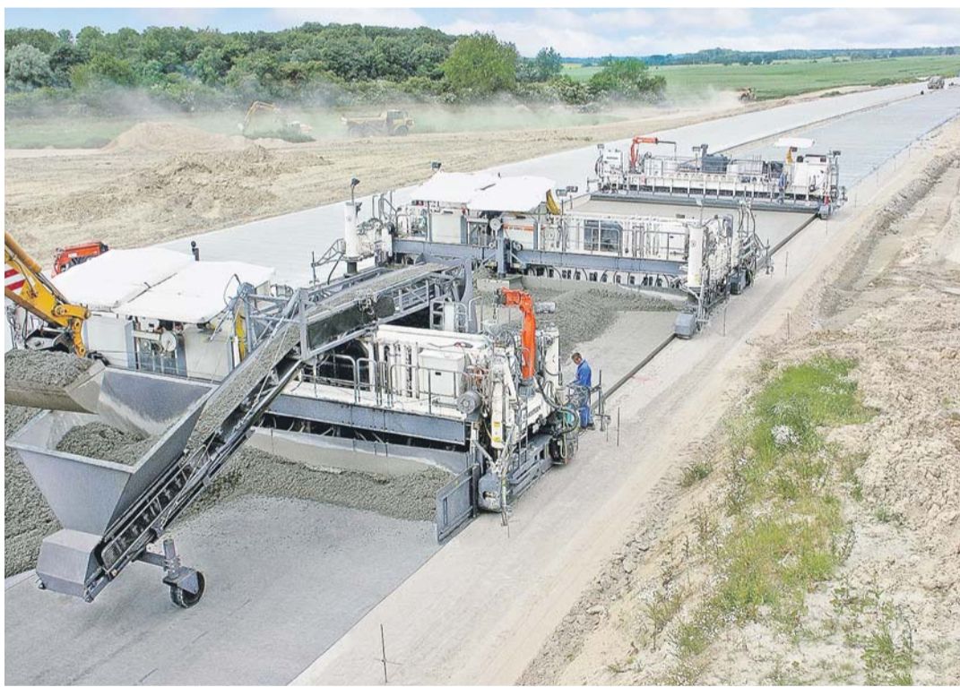
A1 ehitamine Trieri lähedal. Ehitaja – Berger Bau. Alumisse betoonikihti on paigaldatud ka tüüblid ja külgakrud. Käib pealmise betoonikihi paigaldus.
