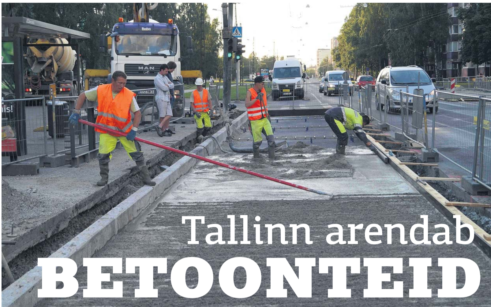
Betoonist bussitasku ehitamine Sõle tänaval.
