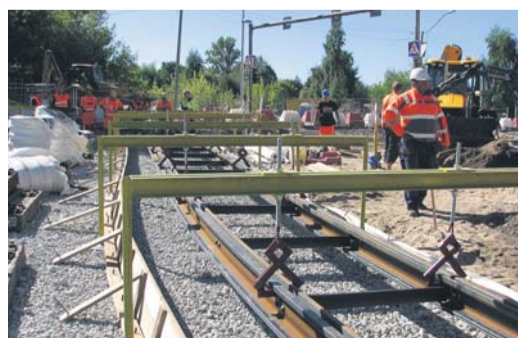
Trammitööde ehitus betoonalusele.
