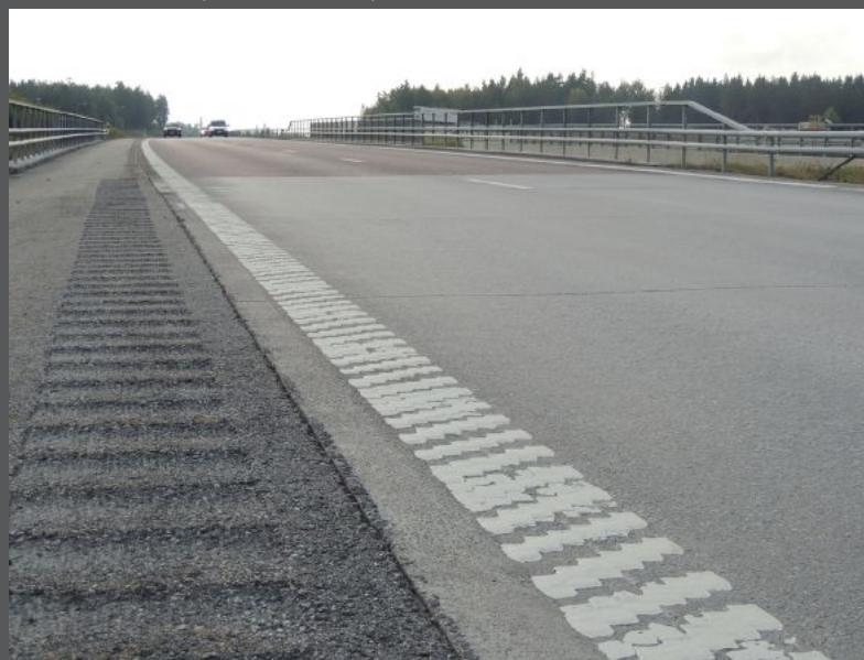
Vaade betoonteelt remonditud silladekile, Uppsala - Mehedeby vaheline maantee. (Foto: Ain Kendra)
