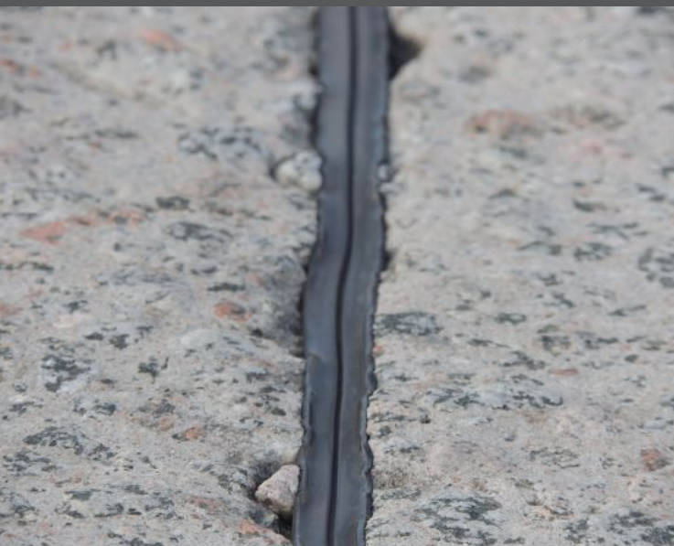
Betoonkatendi remondis paigaldatud uus vuugitihend, Uppsala. (Foto: Ain Kendra)
