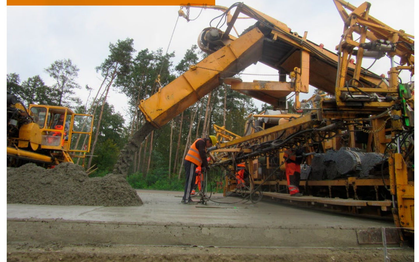
Kahekihilise betooniteede ehitus Poolas (foto: Enno Rebane).
