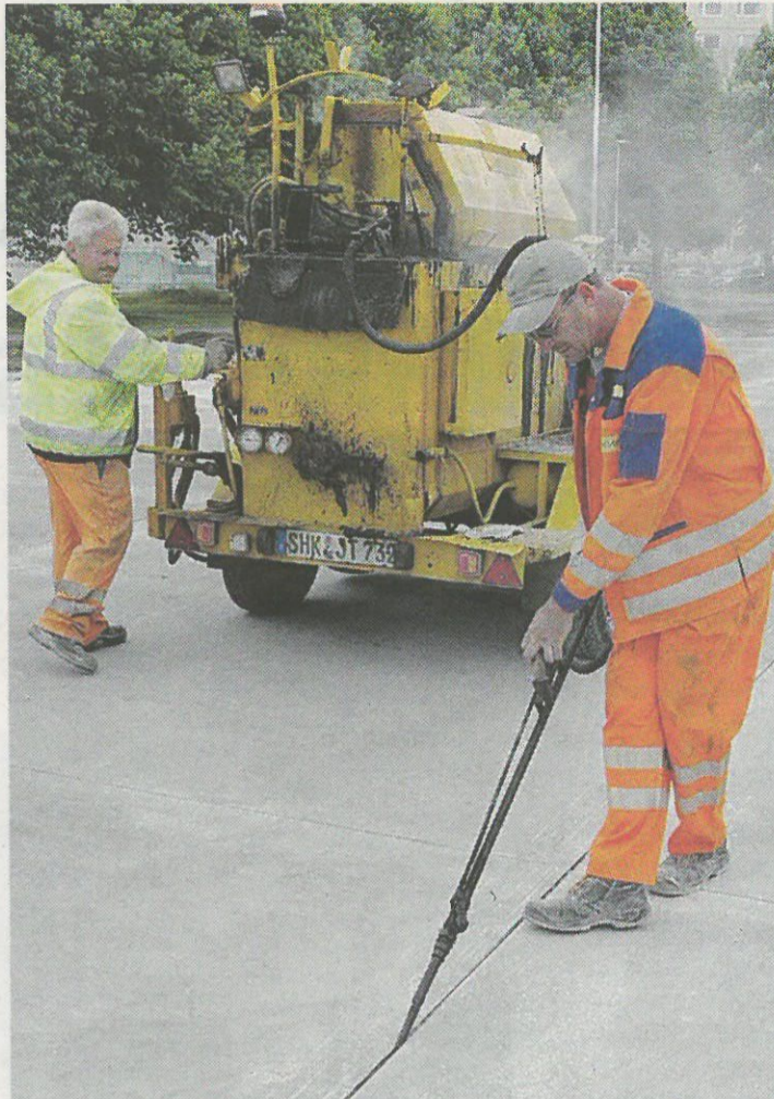
Betoonteed rajades peaks selle osade vahele jätma spetsiaalse seguga täidetud vuugid, et temperatuuri kõigudes saaks betoon paisuda või kokku tõmbuda. Betoontee lõigu ehitamine Õismäele.
