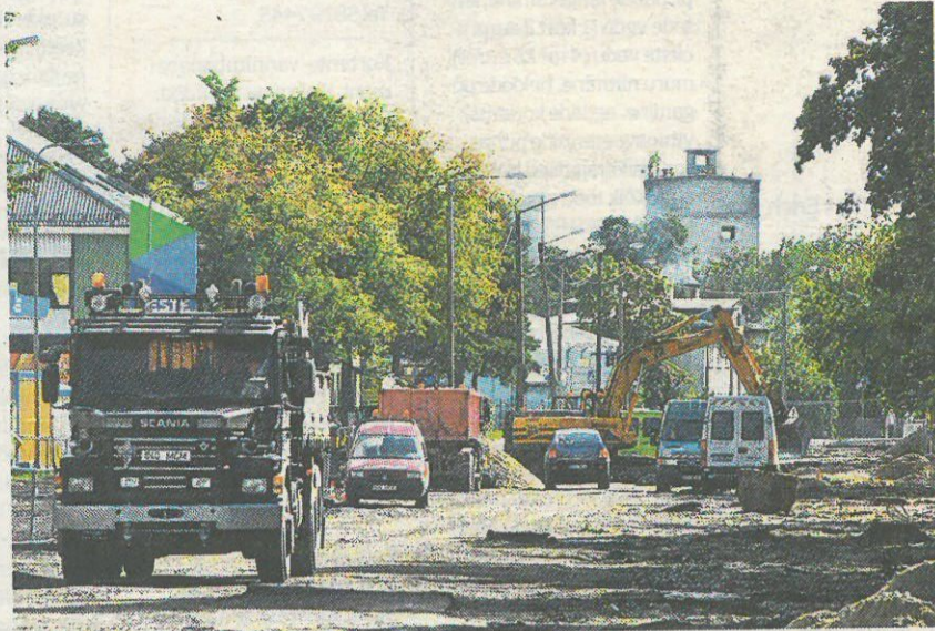
Männiku tee kapitaalremont 2007. aastal, mille käigus vana betoontee lammutati.
