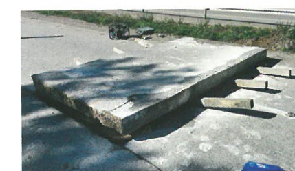
Peterburi tee betoonteelõik, 2014. Näidisplaadi väljasaagimine Maanteemuuseumile. FOTO: MAREK TRUU
