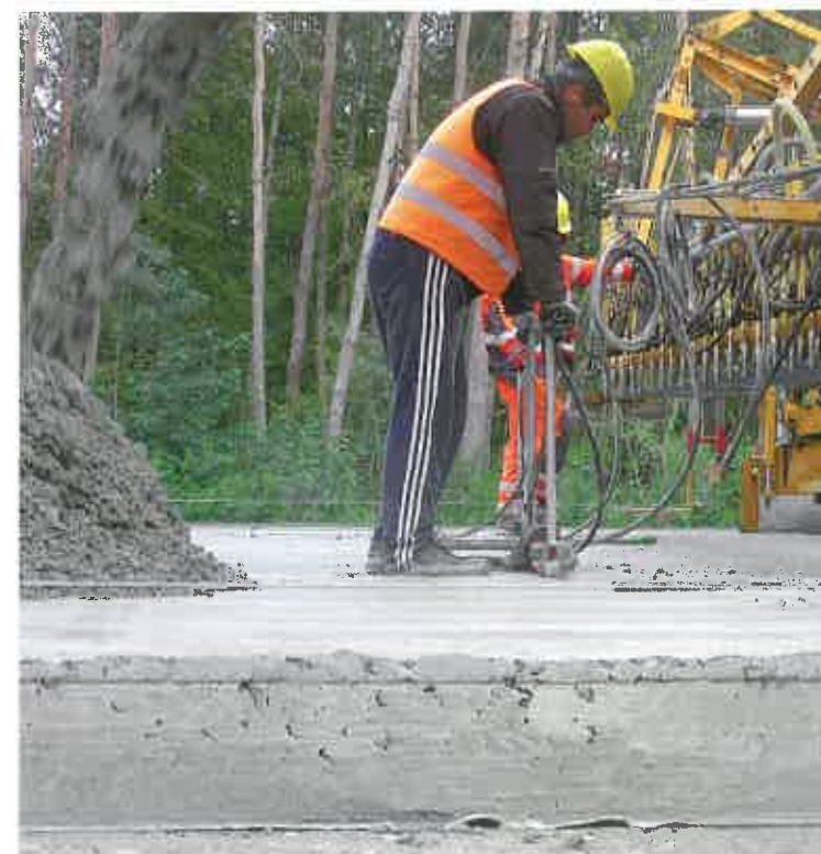
Двухслойное бетонное покрытие (Two Layer Concrete). Польша, 2017, строительство дороги S8
