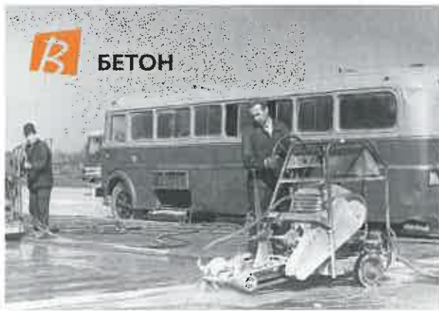
Строительство участка дороги Таллинн-Маарду в 1964-1967 гг. Архивное фото
