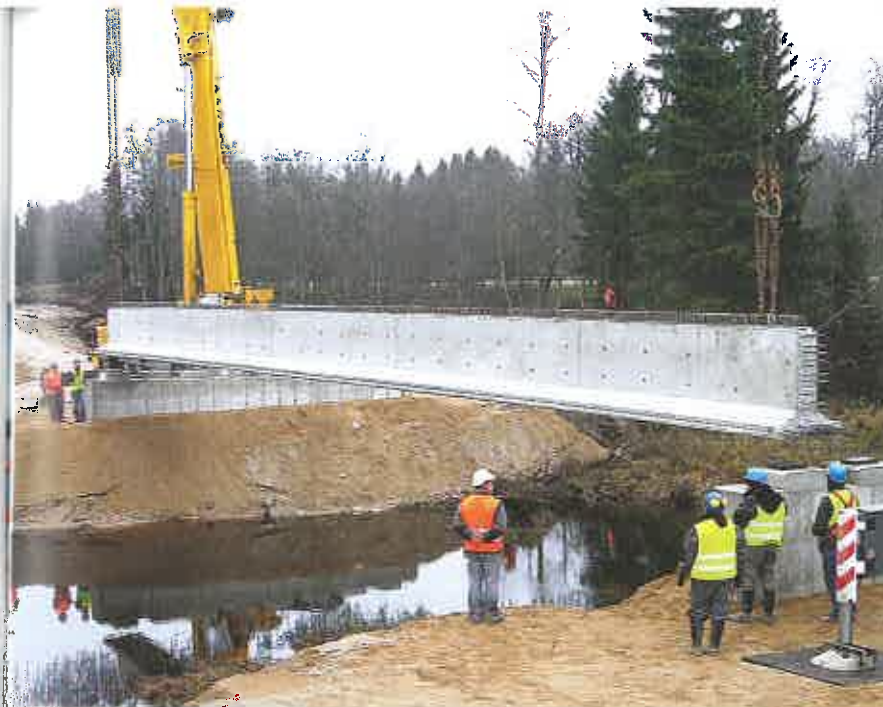
Строительство моста Урва в Арувалла-Коэе 2011. Балка ZIP 30 м. AS E-Betoonelement
