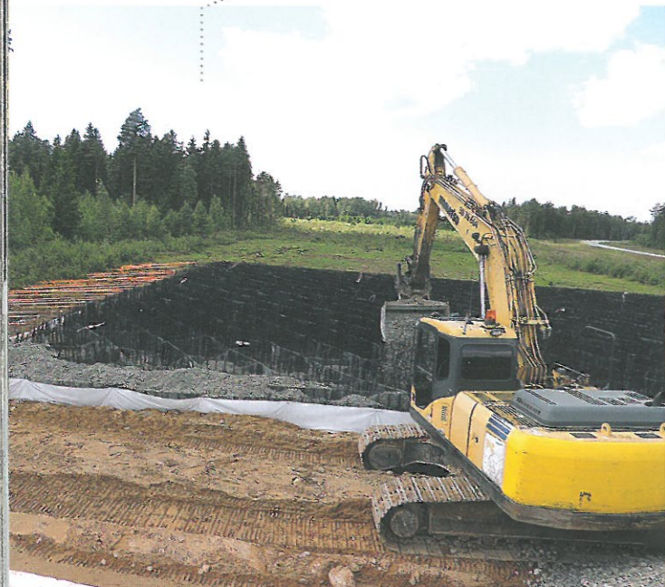
Sektsioon 4 ehitus, kergkruusa katmine geotekstiiliga.
