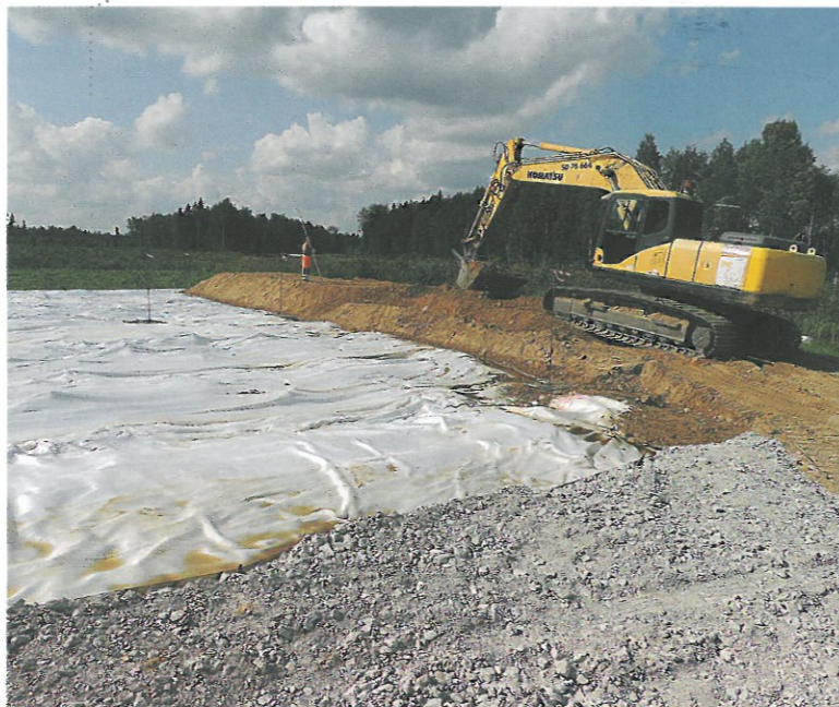
Sektsioon 4 ehitus, tehakse ettevalmistusi kergkruusa paigaldamiseks.
