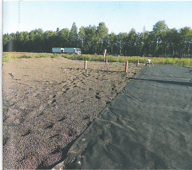
Sektsioon 3 ehitus, toimub geokärje täitmine killustikuga.
