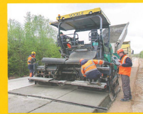
Betoon valatakse teele asfaldilaoturiga, mis on üks RCC-tehnoloogia säästunipp.
