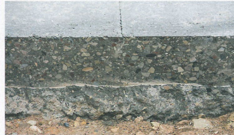
↑ BETONISEGU paigaldatakse RCC puhul asfaldilaoturiga.
